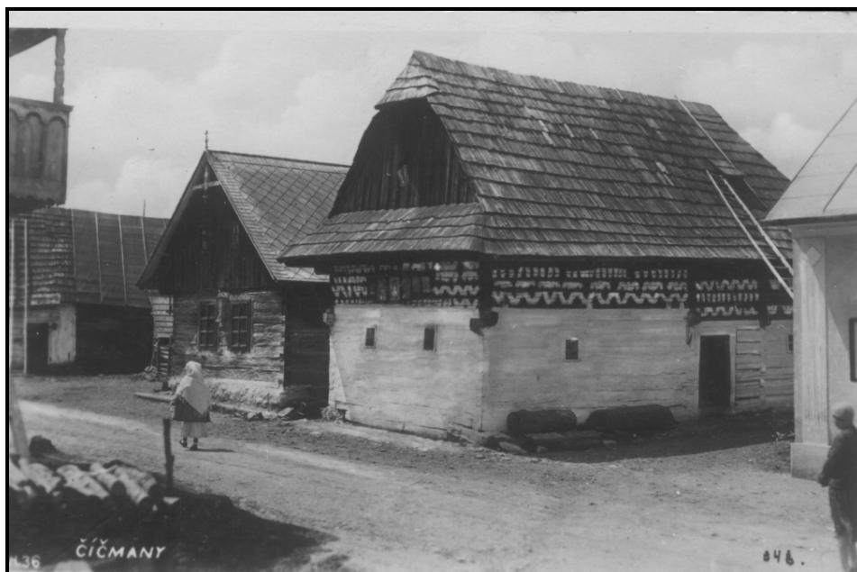
Obr. 8 Prízemné domy s podstrešnými komorami č.42 a 44 (foto 1928)
